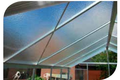
6. Schroef alle bouten en trekklatten aan
