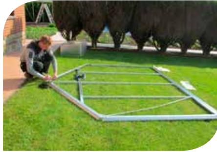
2. Monteer zijgevels en kopgevels
